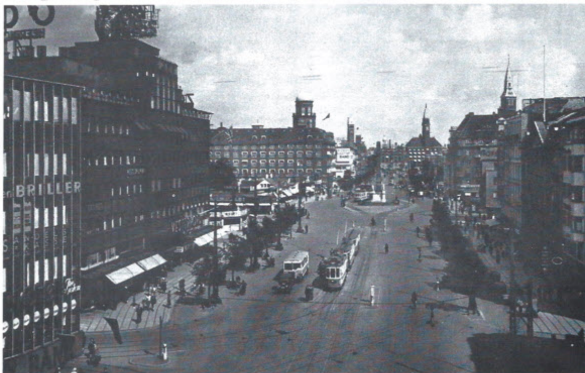
Vesterbros Passage 1938. Frihedsstøtten er ved boulevardbanens anlæg blevet flyttet lidt. Kørebanerne er helt omlagt. Rådhusårnet, Helligåndskirken og Vor Frue Kirke skimtes, men ellers beherskes billedet af de nye bygninger: Vesterport, Axelborg, Bristol og Paladshotellet med deres tårne.
